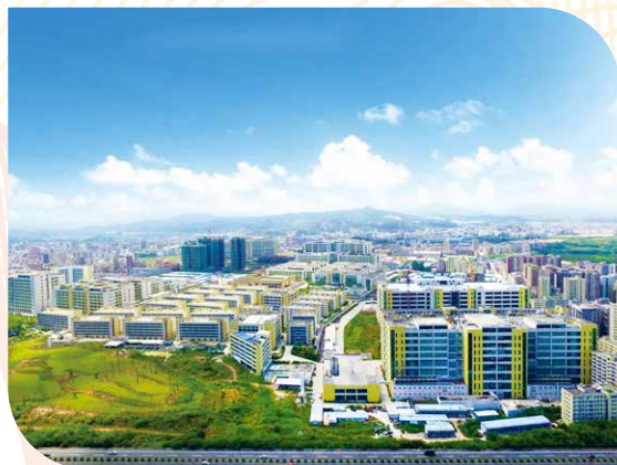
Huizhou Qiuchang Production Base 惠州秋長生產基地
